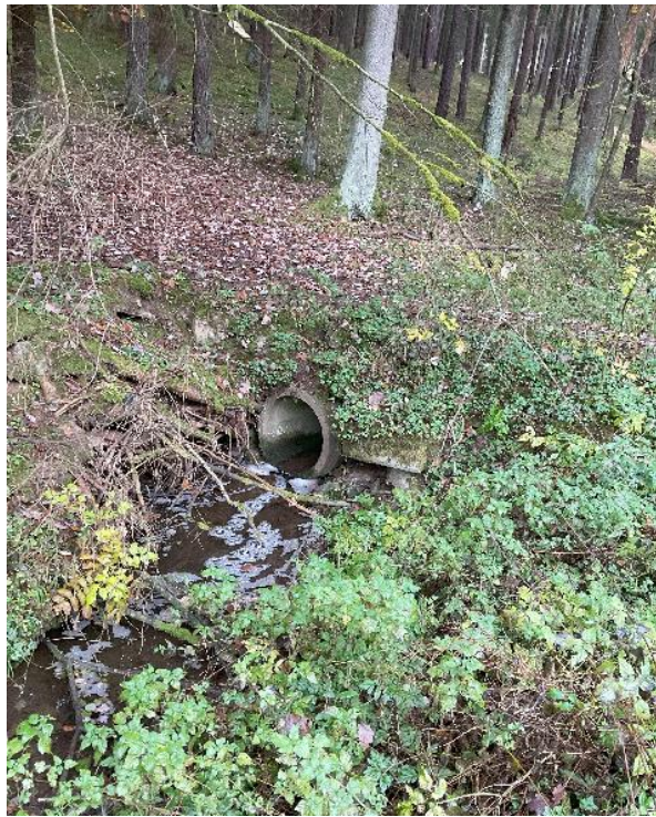
Abbildung 3: Durchlass am Thumbach (Bauwerks-ID 3700000051889)
