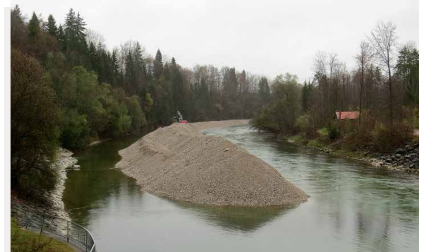
Blick von der Stufe Bad Tölz Isar-abwärts nach Einbringen des Geschiebes. (Abb. 22)
