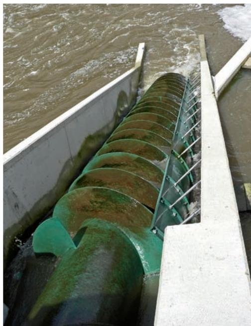
Durch eine Wasserkraftschnecke kann in Restwasserstrecken der Abfluss erhöht werden, ohne komplett auf eine energetische Nutzung verzichten zu müssen. Die Schädigung von Fischen ist dabei weitaus geringer als an konventionellen Turbinen.
