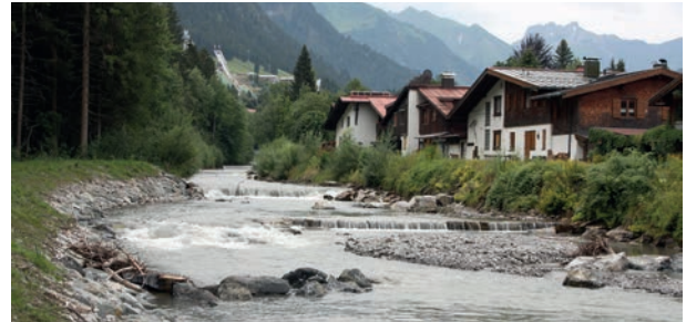
Die Trettach wurde aufgeweitet und zur Verbesserung der Gewässerstruktur wurden Bühnen und Totholz eingebracht.
