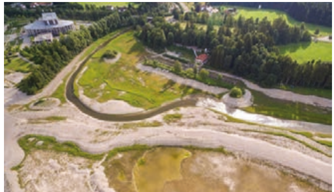
Normalerweise steht das Wasser im Sommer bis zum Fischerheim (rotes Dach). Links oben ist das Festspielhaus zu sehen.
