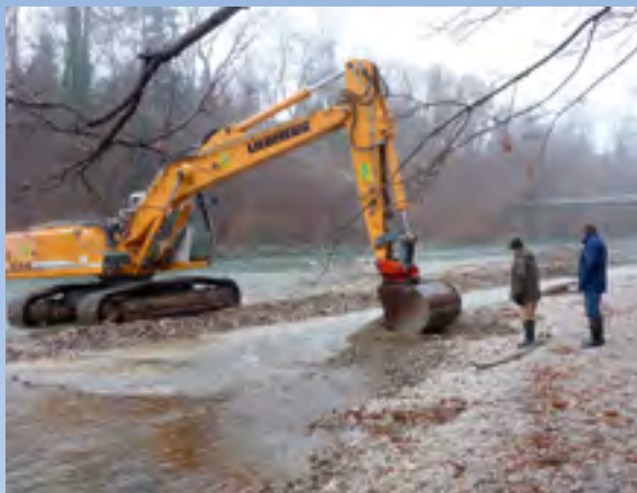
Um geeignete Laichplätze im Lech zu schaffen wurden hier Kiesbänke umgeschichtet.
