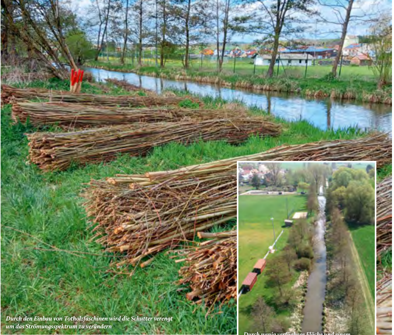
Durch wenig verfügbare Fläche und einem kanalartigen Verlauf der Schutter kann in erster Linie mit sogenannten „In-Stream“-Maßnahmen (im Flussbett liegenden Maßnahmen) gearbeitet werden
