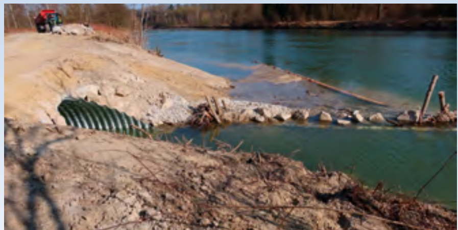
Eine Strukturbuhne verbessert die Durchströmung des Einlaufbereiches.
