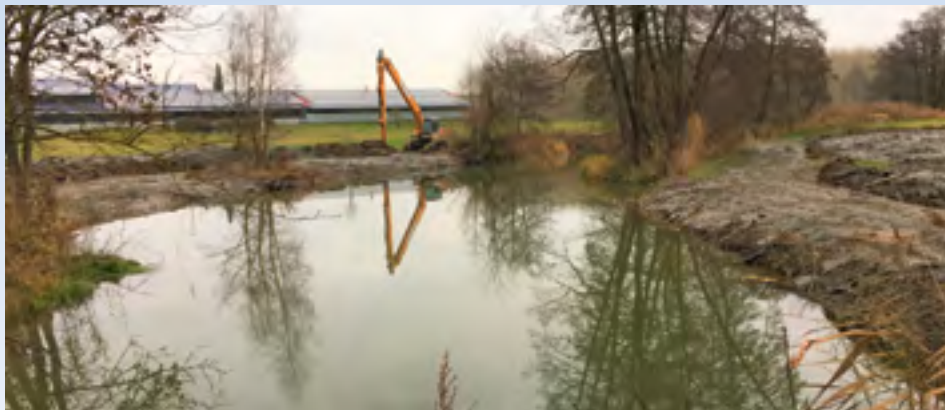
Baggerarbeiten an der Ausleitungsstrecke der Bina bei Morolding, Markt Gangkofen
