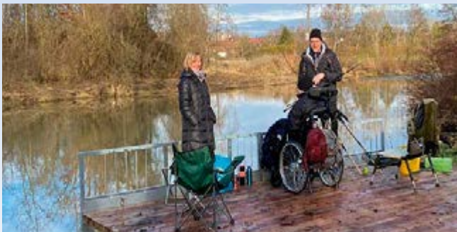
Der FV Aldersbach baute einen behindertengerechten Angelsteg an der Kollbach.
