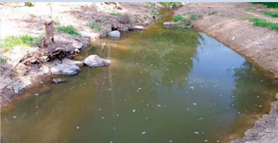
Neu angelegter Sandfang.
