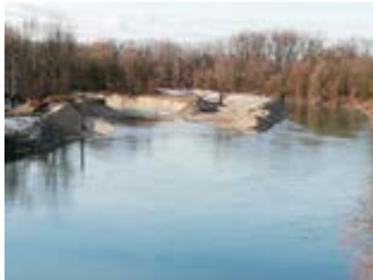
Der Nebenarm wird ausgebaggert, Januar 2020.
