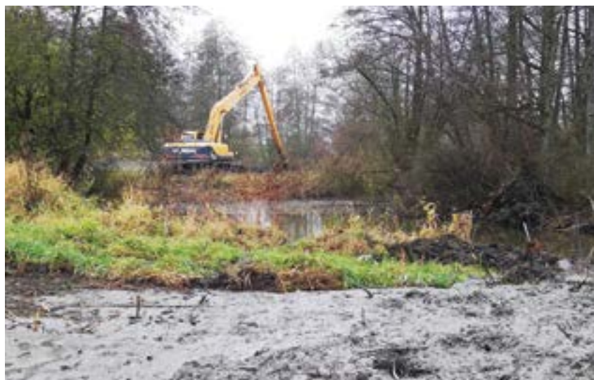
Die Teilentlandung des Vilsaltwassers bei Sommershausen wurde im Frühjahr 2020 abgeschlossen.
