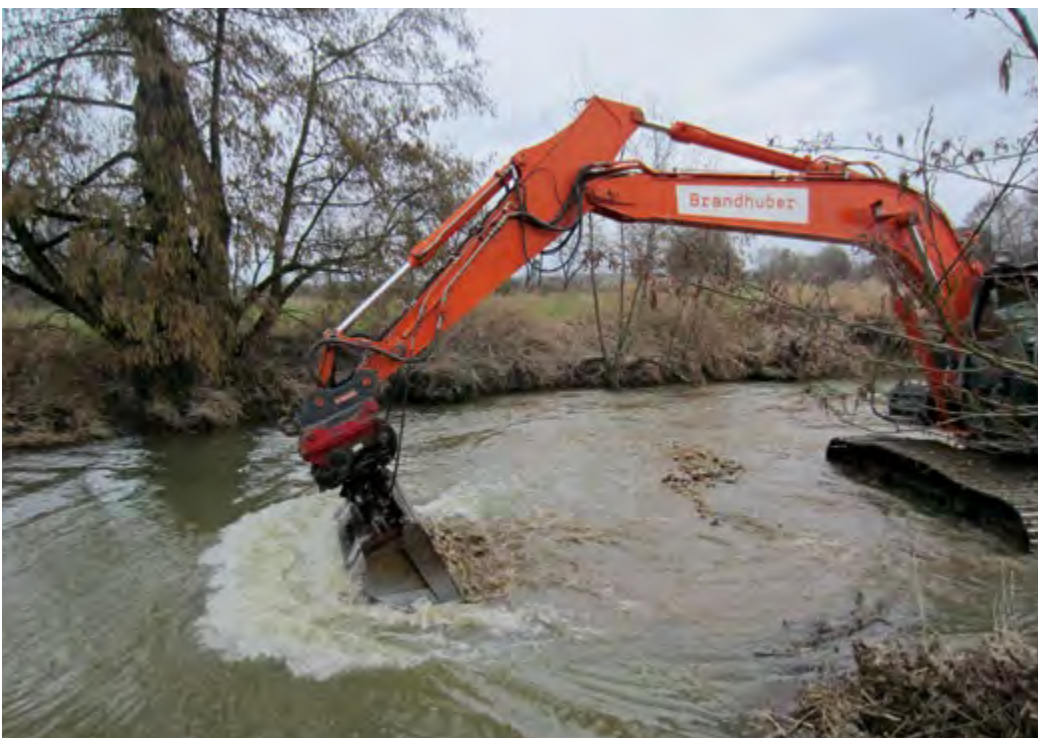
Links: Renaturierungsarbeiten mit schwerem Gerät
