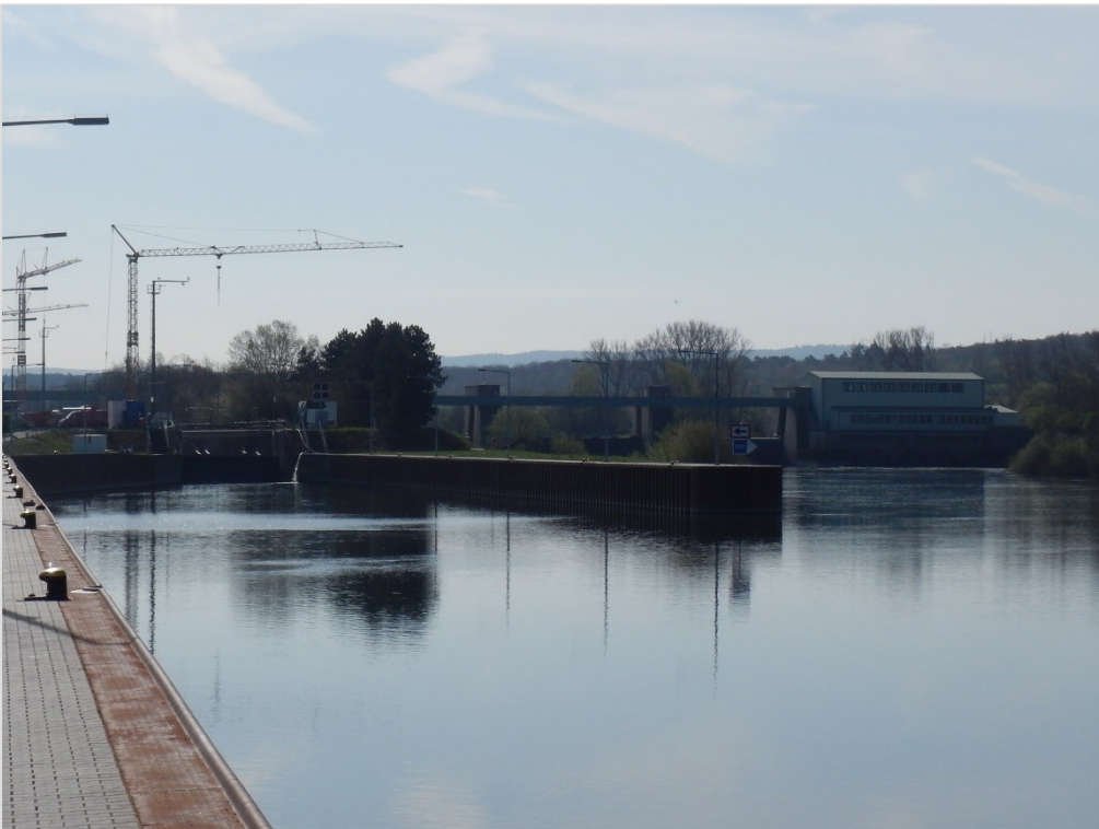
Abbildung 64 WKA4 Wasserkraftwerk und Schleuse in Dettelbach
