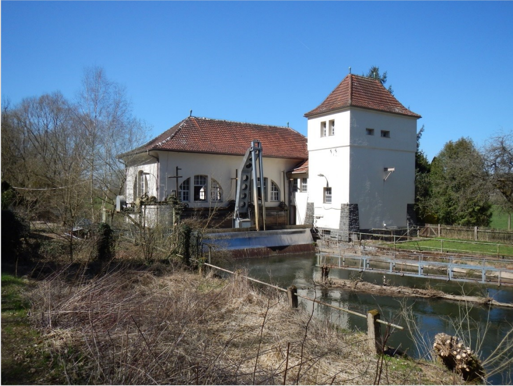
Abbildung 63 WKA3 Wasserkraftwerk in Maineck
