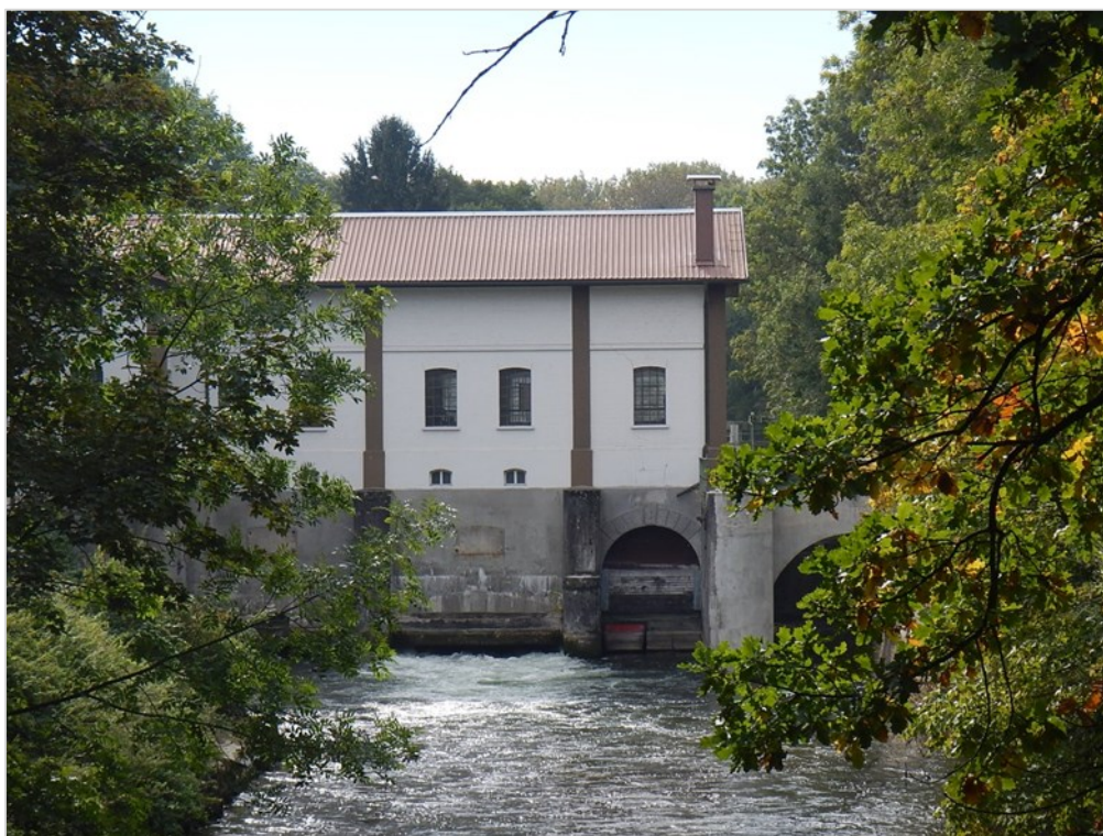
Abbildung 62 WKA2 Wasserkraftwerk in Olching
