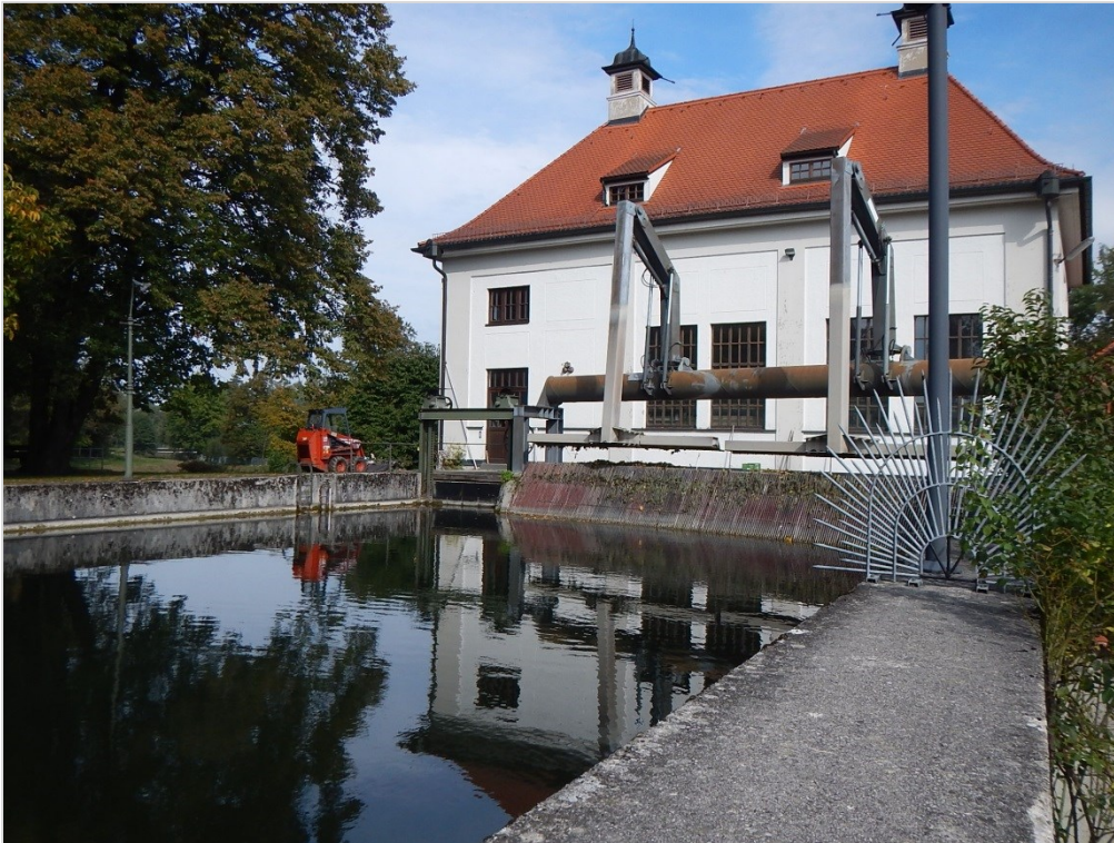
Abbildung 61 WKA1 Wasserkraftwerk In Olching
