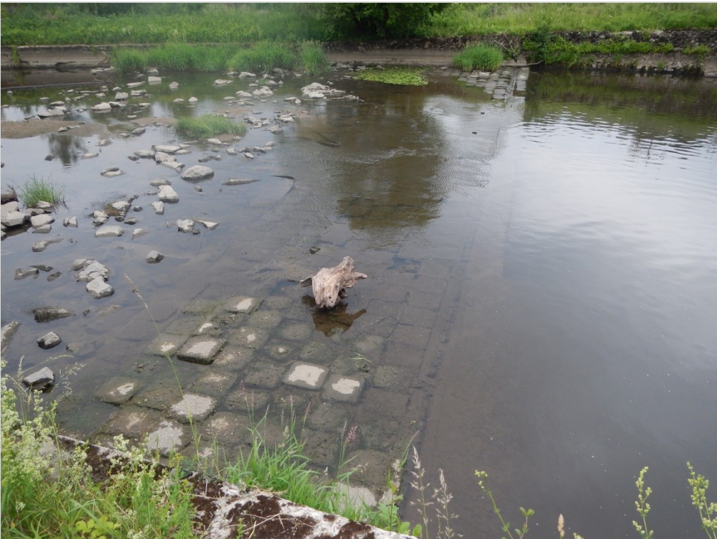
Abbildung 73 Wanderhilfe des Wehrs zwischen M1 und M2 in Maineck
