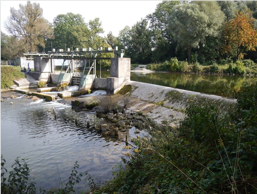
Abbildung 68 Wehr zwischen AP2 und AP3 in Olching
