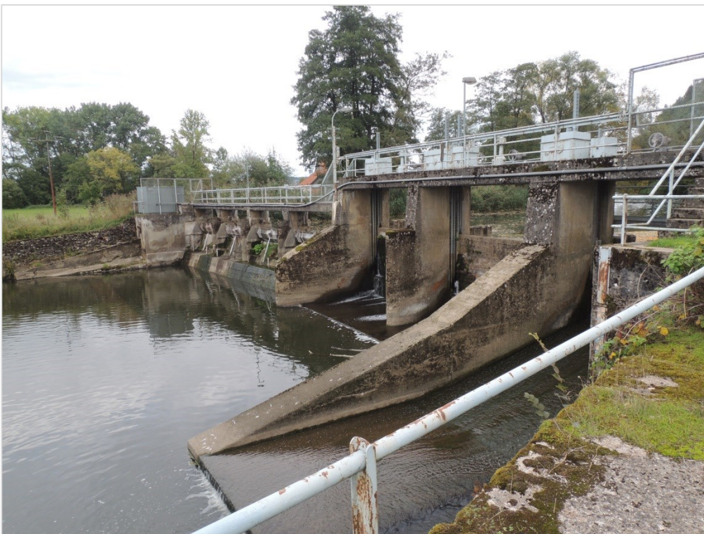
Abbildung 69 Wehr zwischen M1 und M2 in Maineck
