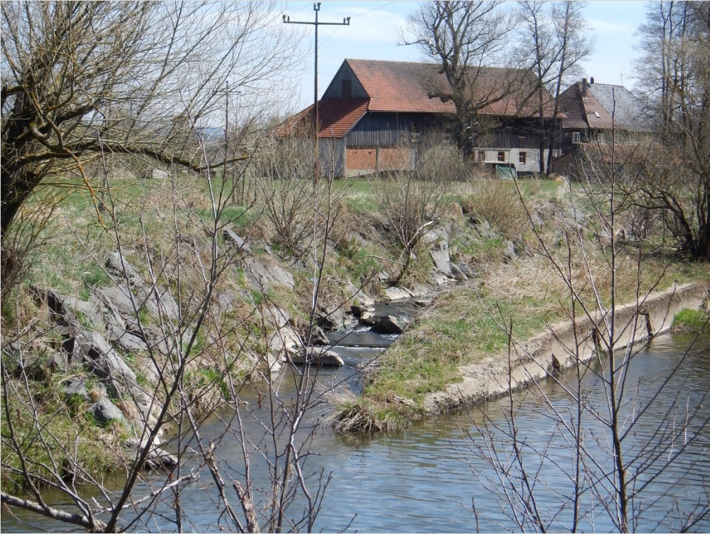
Abbildung 72 Wanderhilfe des Wehrs zwischen M1 und M2 in Maineck
