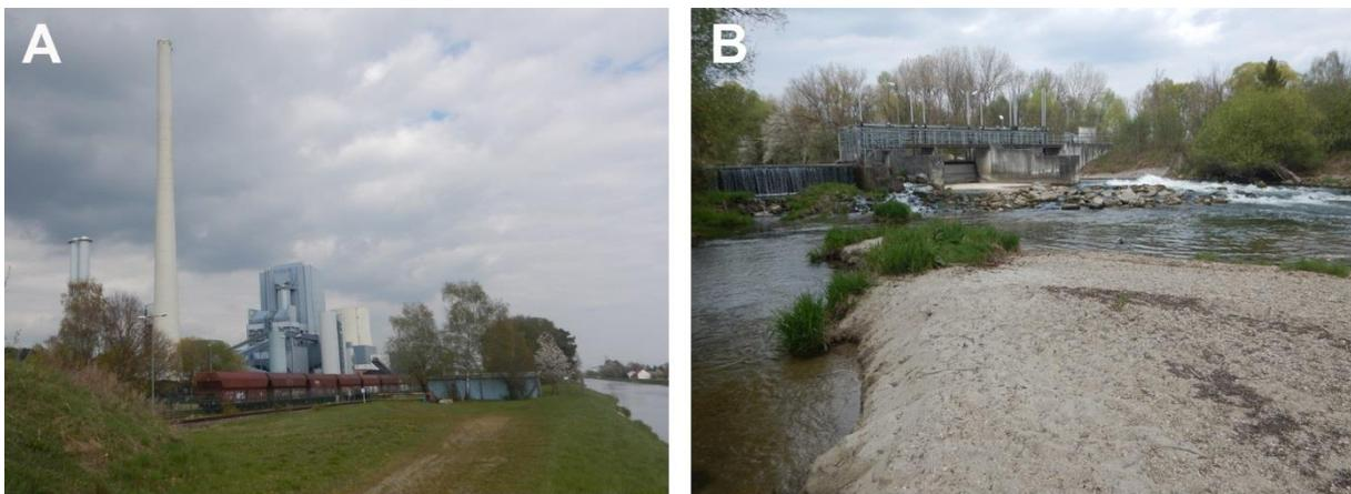
Abb. 1: Das Steinkohle Kraftwerk Zolling an der Amper mit Werkkanal (A), Ausleitungsbauwerk an der Amper mit Fischaufstiegsanlage und Umgehungsgerinne (B).
