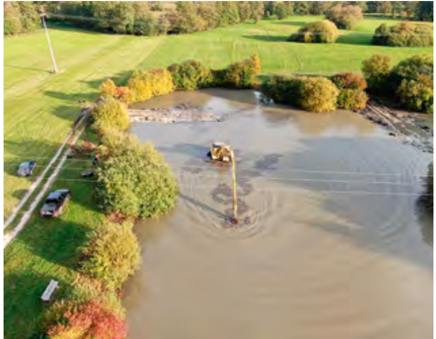
Baggerarbeiten im Dietfurter Laaberweihers .
