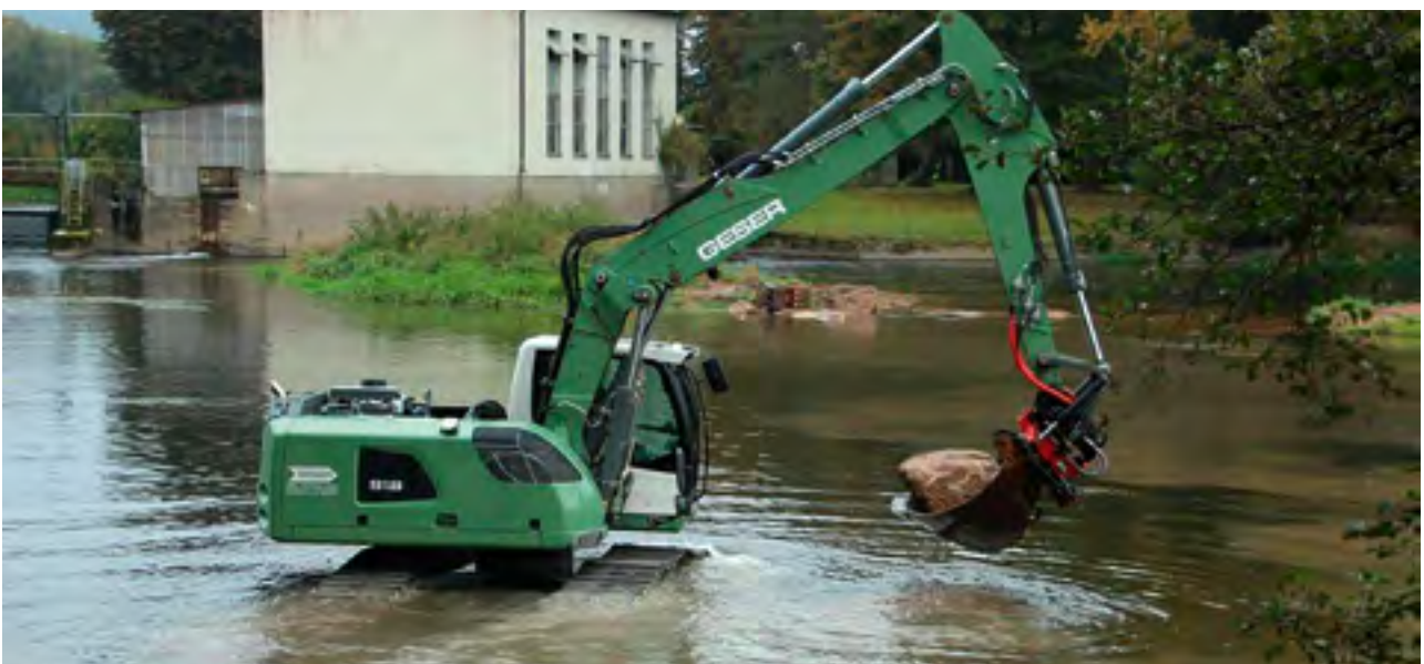
Setzen der Störsteine in den Regen unterhalb des Rampsauer Wehrs.
