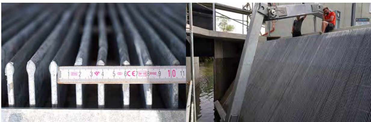
Abbildung 77: Mechanische Barrieren durch Feinrechen (hier ein schräg gestellter 13 mm Feinrechen mit anschließender FAH als Bypass an der Gr. Mühle) können – je nach lichtem Abstand - Junghuchen in der Regel erst im zweiten Lebensjahr effektiv vor der Turbinenpassage schützen.
