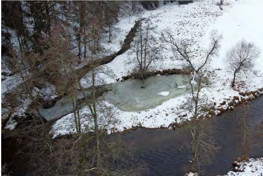
Abbildung 82: Vor wenigen Jahren hergestellter, einseitig angebundener Altarm und Grabensystem an der Ilz flussab Rosenbergersäge. Die Eisbildung führt zu einem zusätzlichen Schutz überwinternder Fische. Foto 30.1.2020.
