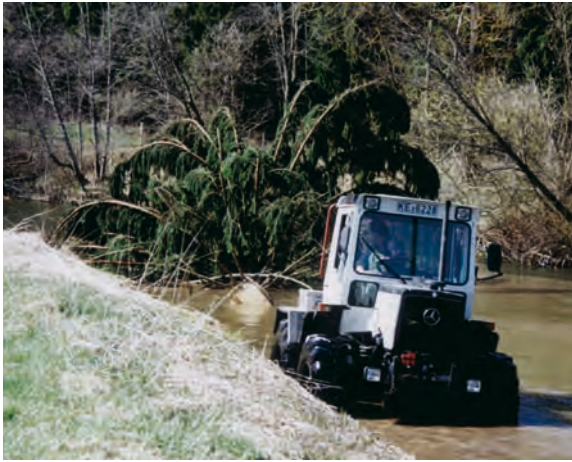
Totholz einbau an der Wertach
