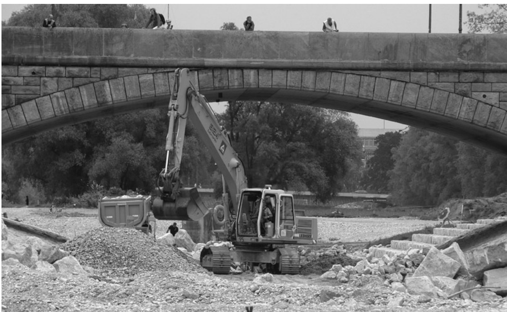
Abb. 21: Naturnahe Erweiterung des Flussbetts. Hochwasserschutz und Renaturierung im Einklang
