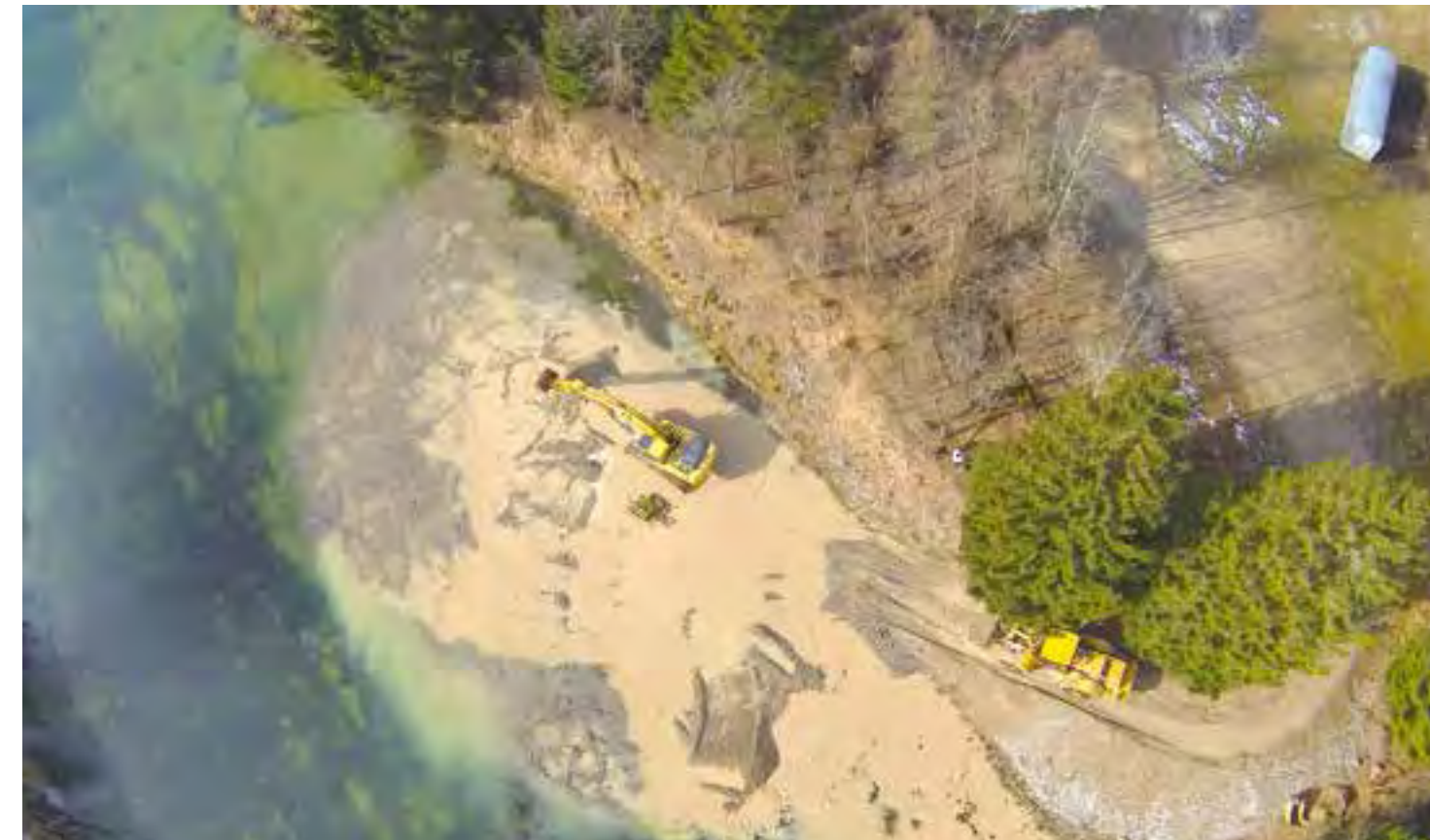
Laichplatzsanierung durch Kieszugaben am Lech bei Apfeldorf
