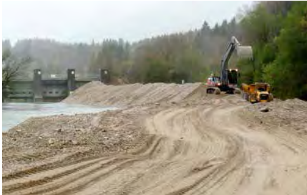
Maßnahmen im Rahmen einer Geschiebemanagement an der Isar unterhalb des Kraftwerks Bad Tölz
