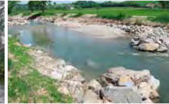
Links: Einbau von Störsteinen in einem Huchen-Gewässer (Ilz)
