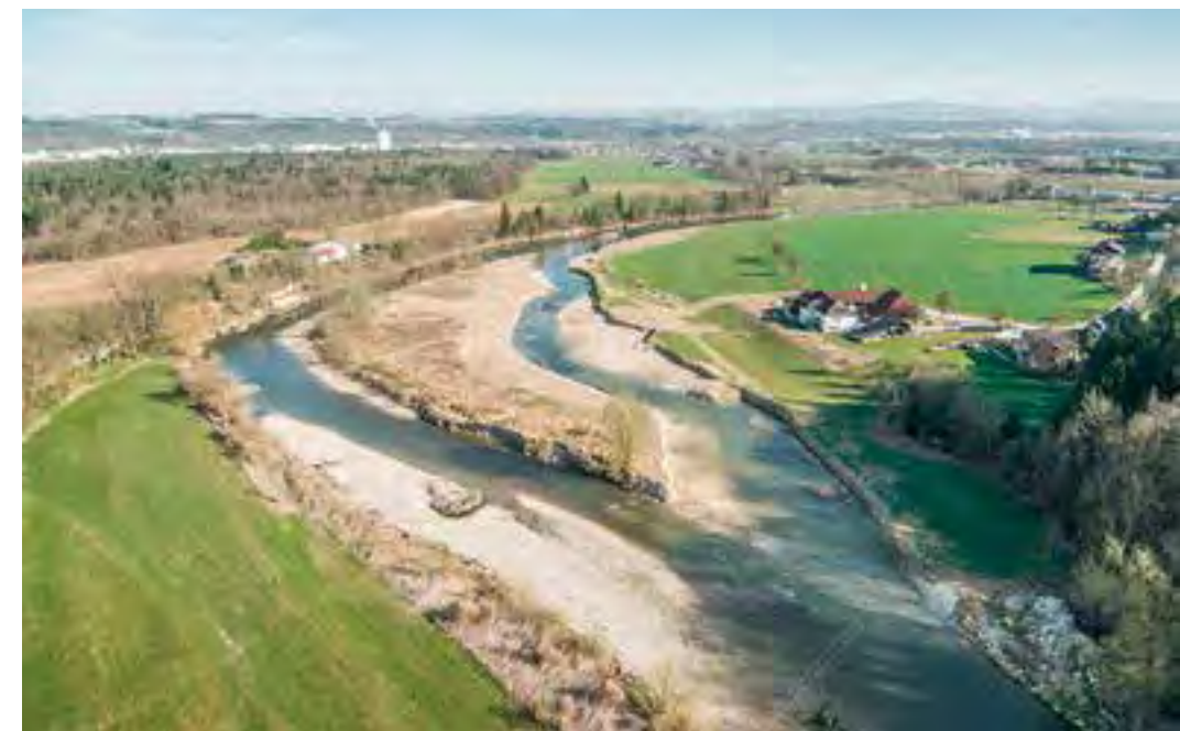
Aufweitung mit Nebenarm an der Ybbs. Hier hat sich im letzten Jahrzehnt ein guter Huchenbestand entwickelt.
