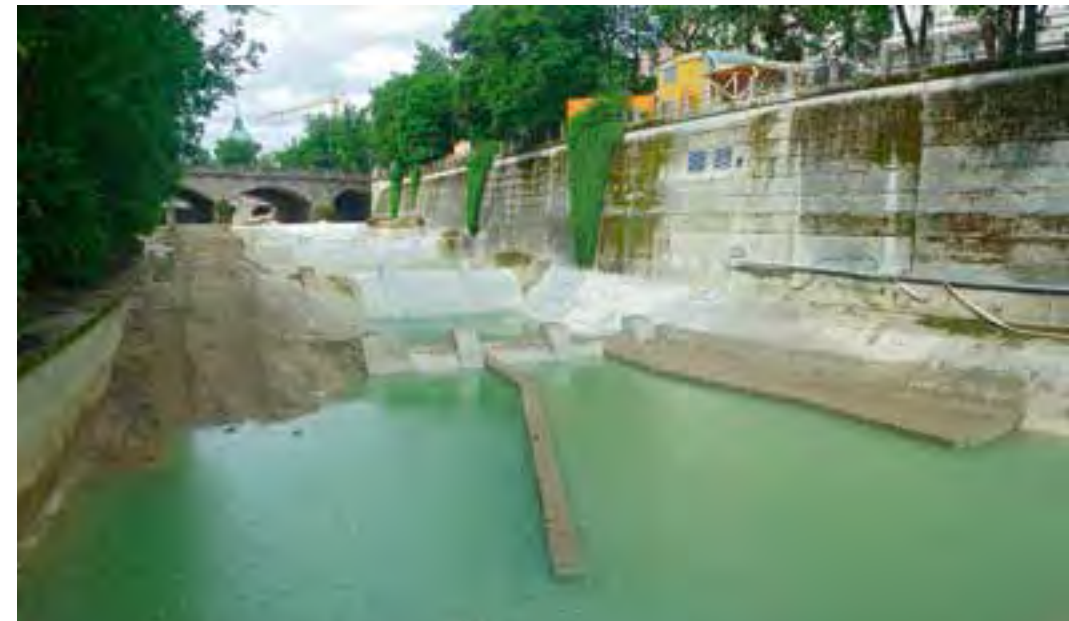
Bildmotiv links: Im Zuge des Erneuerbare Energiesetzes (EEG) entstehen vielerorts neue Wasserkraftanlagen (hier das Praterwehr in München).
