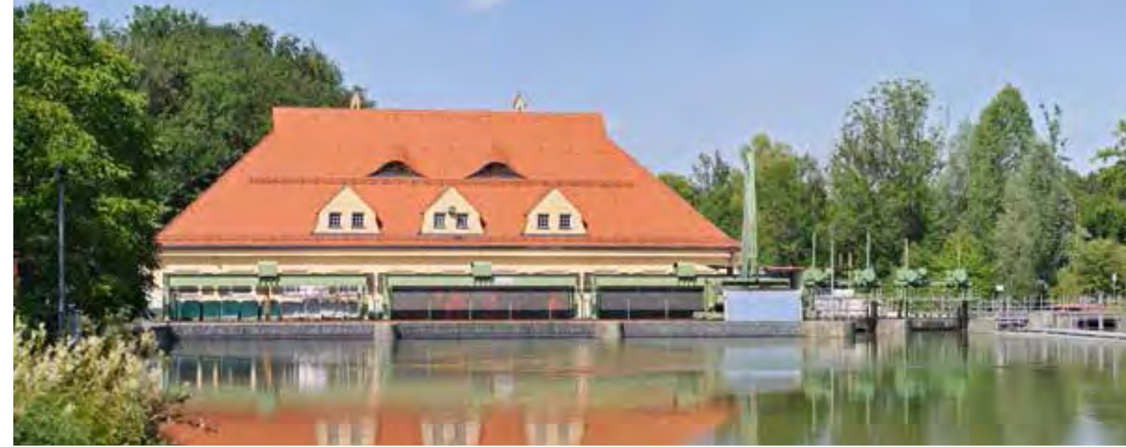
Einlauf eines Kraftwerk an der Isar in München
