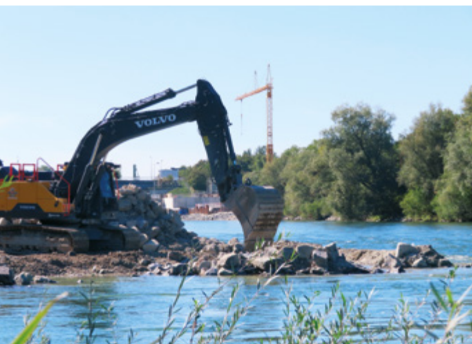
An der Staustufe Landau stehen Kran und Bagger, um reichlich Beton zu verbauen.
