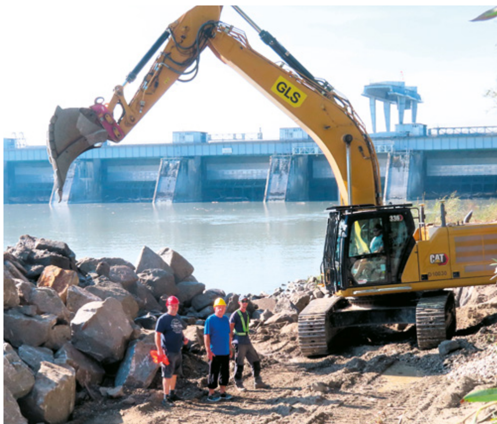
Die Großbaustelle am Kraftwerk Simbach- Braunau soll noch in diesem Jahr abgeschlossen werden.
