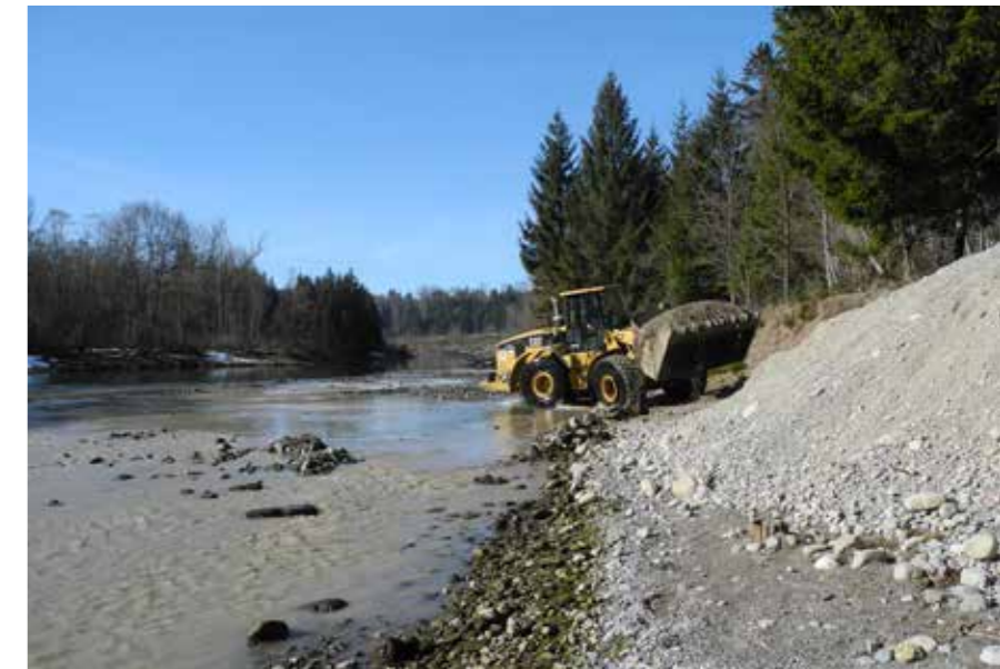
Bild unten: Mit schwerem Gerät wird tonnenweise Kies zur Schaffung von Laichplätzen in den Lech eingebracht.
